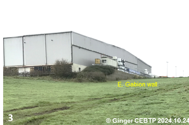
Figure 2-6 : Photo-montage annoté, illustrant les conditions de site le long de la limite sud du projet, ainsi que les murs de soutènement en gabions.
